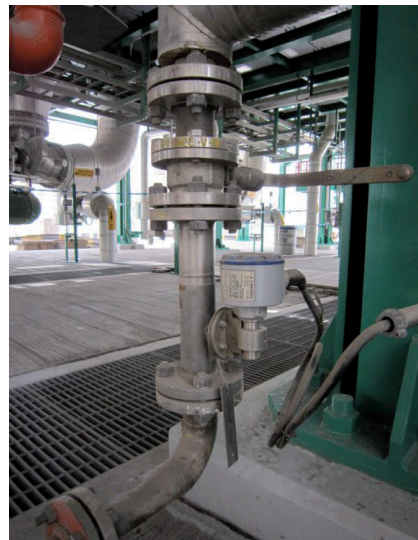
安装于冲淋装置上的 DW 182 EEx d
