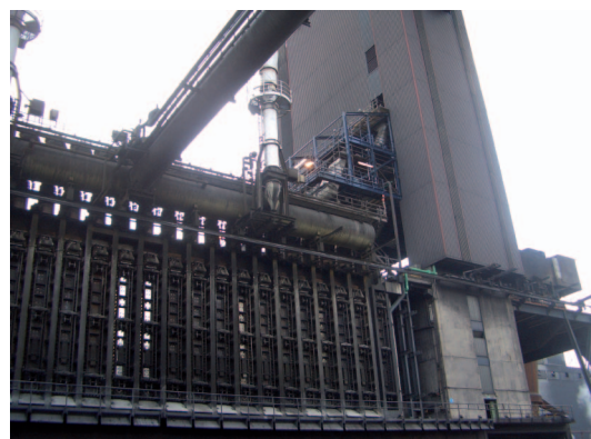
带装料平台的焦炉群(右上方)
