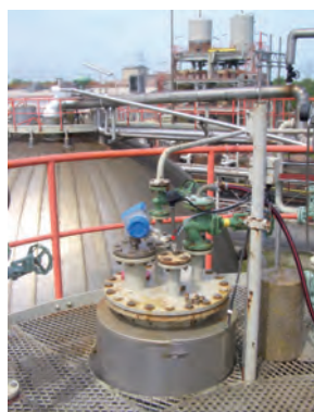
在球罐的顶部： OPTIWAVE 7300 安装在 现有的法兰接头上
