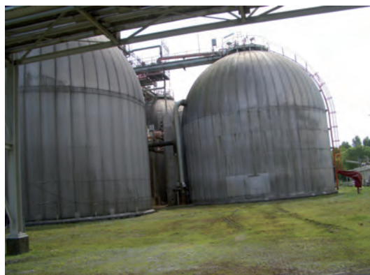
球罐中液氯的液位只允许达到一个预定的高度
