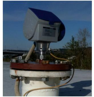
OPTIFLEX 1300 C 安装在分离器顶部
