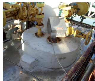
非接触式液位计OPTIWAVE 7300 C 测量氯液位
