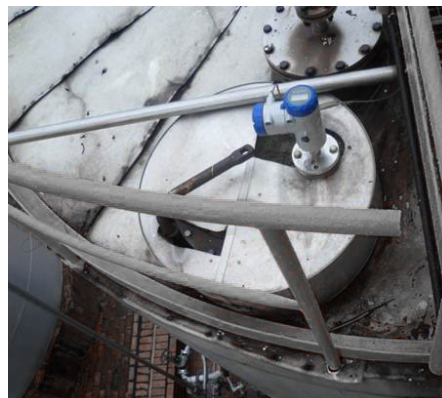
OPTIWAVE 5200 Ex 安装在管的短脖位置
