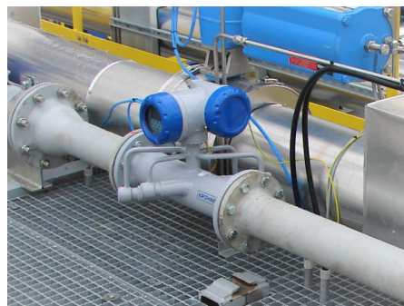
OPTISONIC 7300 超声波流量计，测量氢气流量
