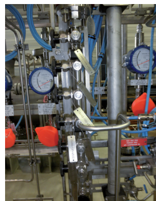
H250 M40 的氮气流量测量
