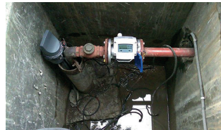
安装在不同地点的 WATERFLUX 3070 C 和 KGA 42
