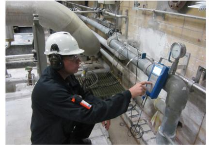
安装在管道上的配有移动信号转换器的OPTISONIC 6300 P
