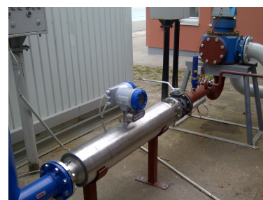
OPTIMASS 2300 C 安装在燃料仓用于监测传输
