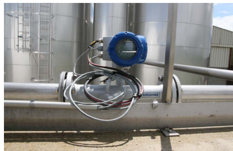
OPTISONIC 7300 Biogas 在消化罐前
