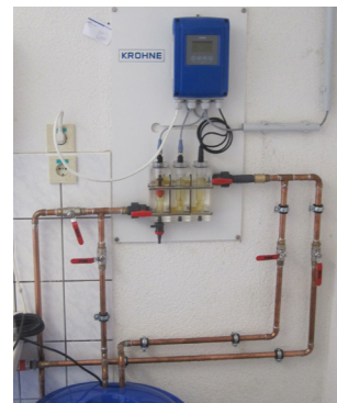
配备测量以及冲洗单元的 OPTISYS CL 1100
