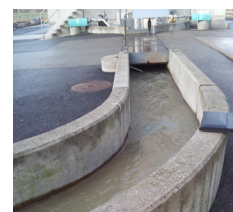
在初隔栅和初级澄清装置之间的明渠
