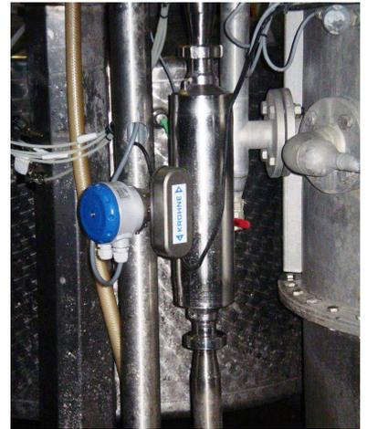
OPTIMASS 1300测量马铃薯发酵液
