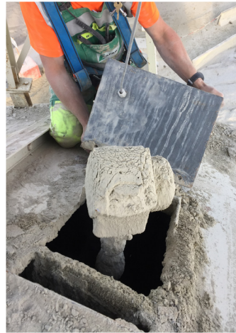
旧的 OPTIWAVE 6300 物位计的拆除
