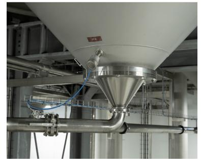
在圆锥形罐的底部安装“从”压力变送器
