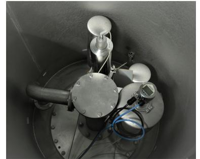
将主压力变送器安装在罐顶的安装短管中
